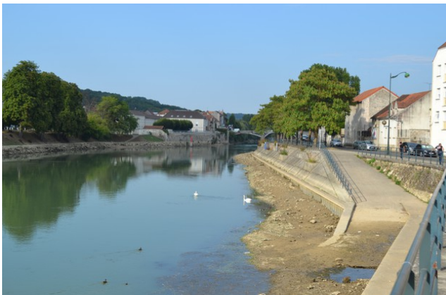
St Jean les 2 Jumeaux - Abaissement du bief de la Ferté
