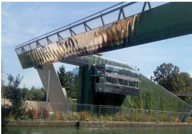
Illustration 1: Passerelle et bâtiment de commande en rive droite. Un bardage en inox habille les poutres en faces extérieures pour capter le reflet de l'eau en partie basse.
