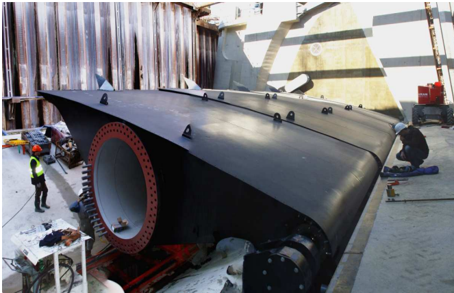
Illustration 1: Pose du clapet au fond du batardeau
